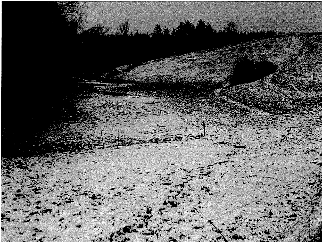
Det rørslagte vandløb i slugten åbnes
